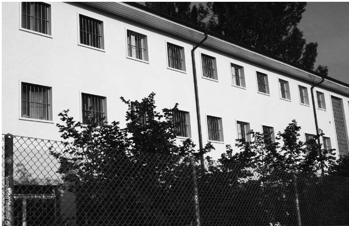
Un nouveau groupe thérapie verra le jour à Hindelbank en été 2011, en lieu et place d'un autre groupe de vie, ce qui ne nécessitera pas de travaux de construction particuliers.
